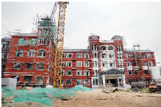
正在建设中的平桥区特殊教育学校 本报记者李亚云摄
