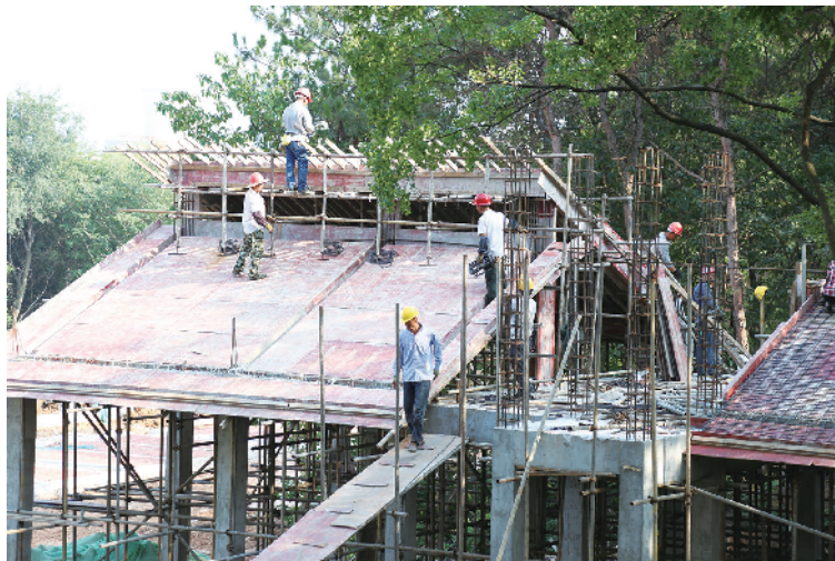
施工现场 本报记者 杨长喜 摄
