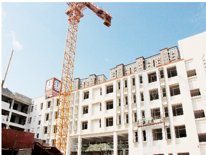
龙江路小学施工现场 本报记者 李亚云 摄
