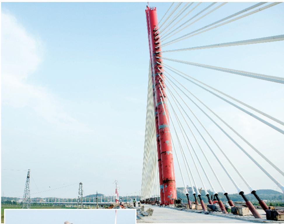
7月23日下午,在息县淮河埠口大桥施工现场,工人正顶着炎炎烈日,进行桥梁护栏和路灯安装。据施工人员介绍,该桥梁全长1590米,宽21米,设计为双向四车道,高标准旅游景观大桥。建成后,从县城到濮公山地质公园将由原来的30分钟车程缩短为5分钟左右,极大方便了市民的出行。
