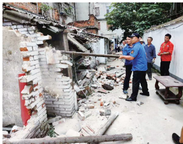
工作人员正在对违章建筑进行拆除 本报记者 吴楠 摄
