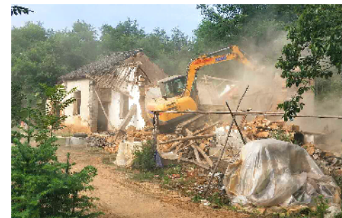
6月27日,泌河区谭家河乡正在拆除一处危房。据了解,为加强南湾湖水污染防治和保持土地占补平衡,近期以来,该乡及时组织人力和机械,对沿河旱厕、畜禽养殖场等散乱污企业和危房改造后没有及时拆除的危房,进行地毯式的统一拆除。
