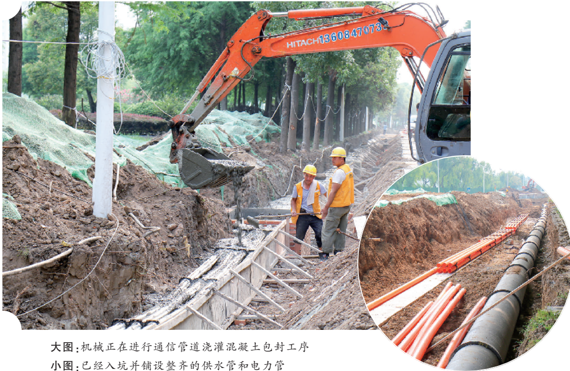
小图:已经入坑并铺设整齐的供水管和电力管
