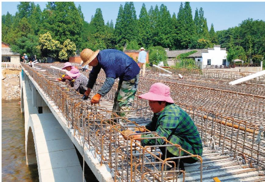
14日上午,浙河电站桥施工现场,工人们正顶着高温施工。据了解,电站桥是横跨浙河南湾水库输水洞尾水渠集交通与景观于一体的过河桥梁,桥宽10米,两侧各设1.5米人行道,中间7米设双向两车道,桥梁核载等级为公路Ⅱ级。目前,工程进度为焊接桥面混凝土铺装层钢筋网。
