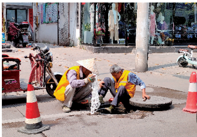
工人们正在解放路上更换防坠网 本报记者 张方志 摄
