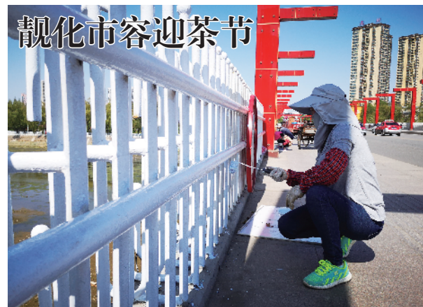
第27届信阳茶文化节将至,昨日,市政管理部门组织工人对城区几座桥梁栏杆进行重新刷漆,靓化市容迎茶节。 本报记者 马依钊 摄
