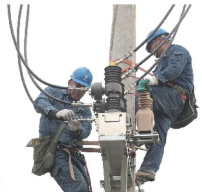
4月10日,潢川县供电公司伞陂供电所员工正在对10千伏伞1线开展集中检修工作,采用“一停多用、综合体检”的方式,对线路进行全面体检、发现缺陷、逐项消缺,确保线路安全稳定运行。徐韵雯 摄
