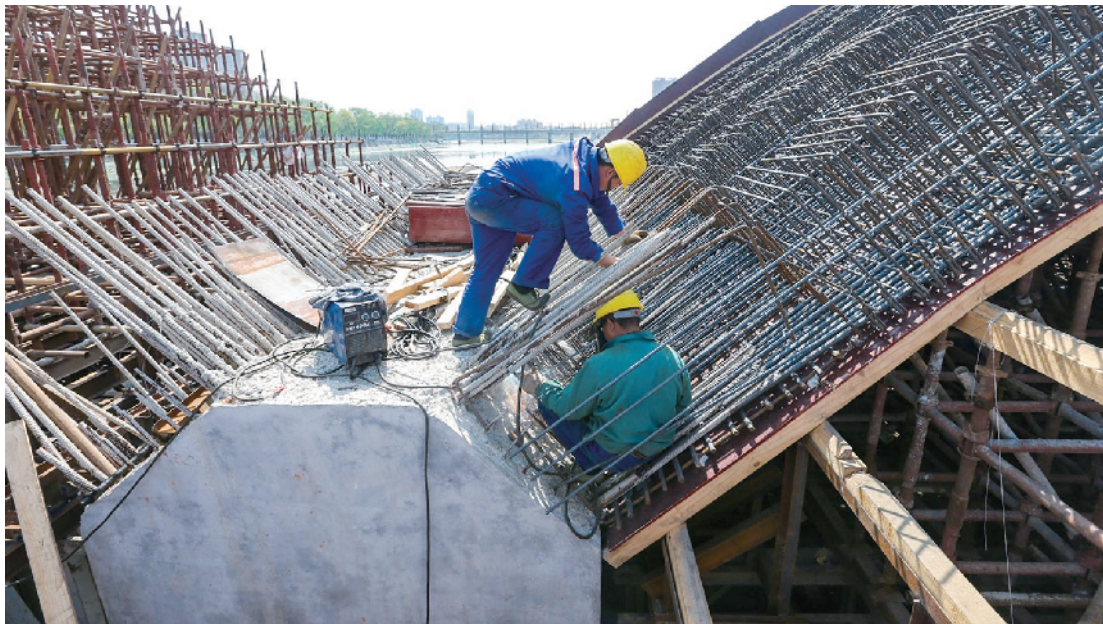
图为工人在浉河公园步行桥上施工 本报记者 王哲摄
