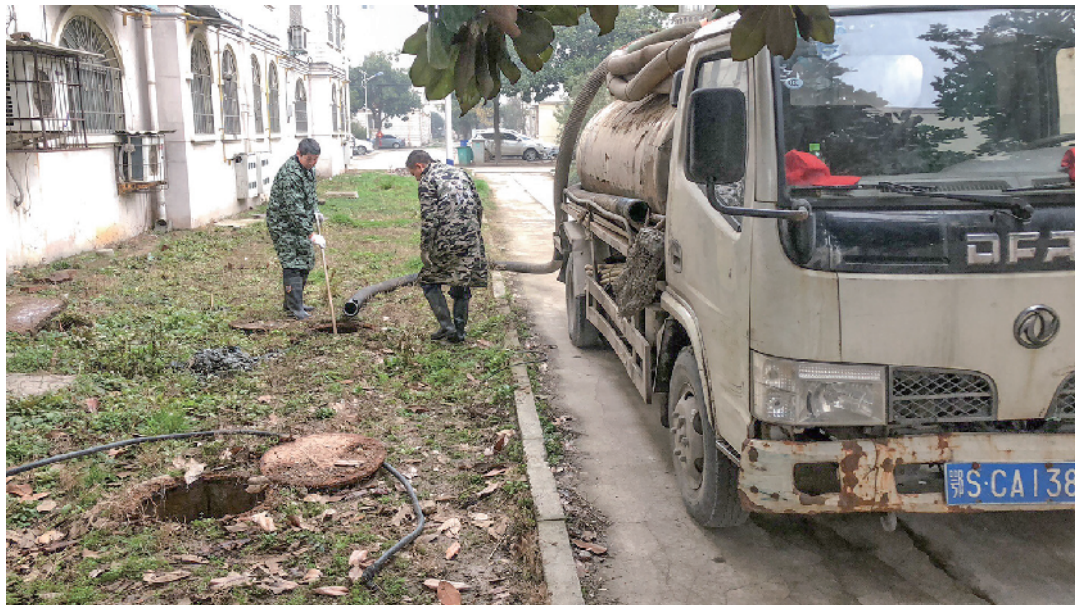
专业疏通人员正在疏通下水道 本报记者 李倩 摄
