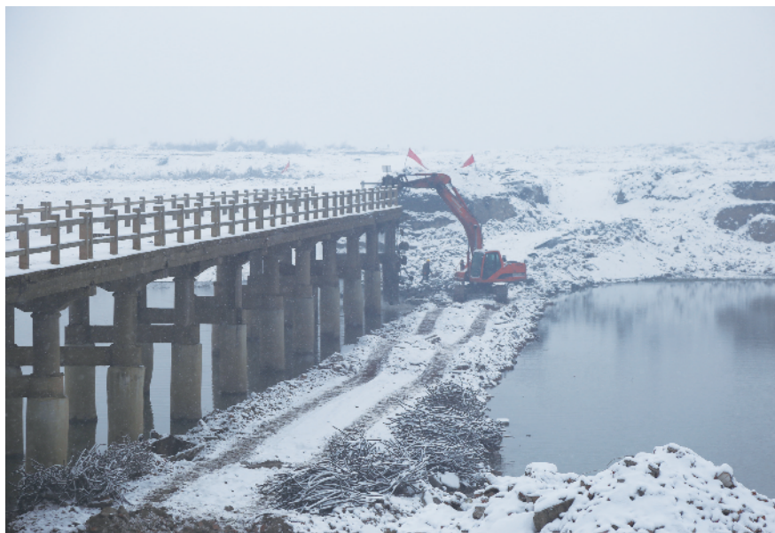
拆除现场 本报记者程云摄
