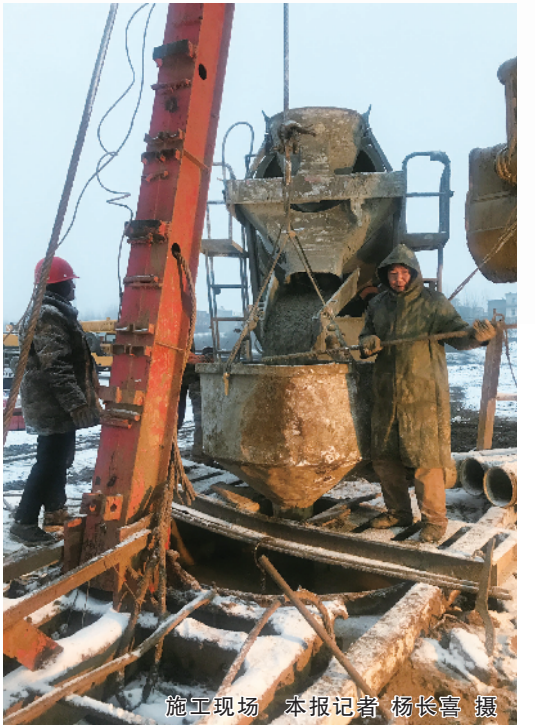
施工现场 本报记者 杨长喜 摄
