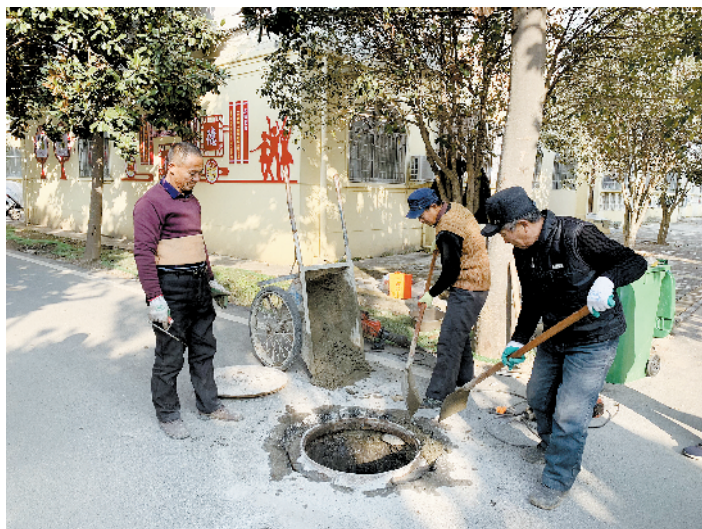
工作人员正在整修井盖 本报记者 李亚云 摄
