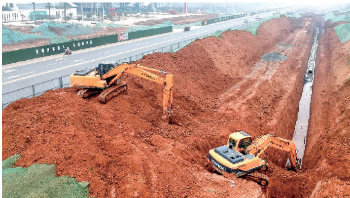
施工现场 见习记者 华祯 摄
