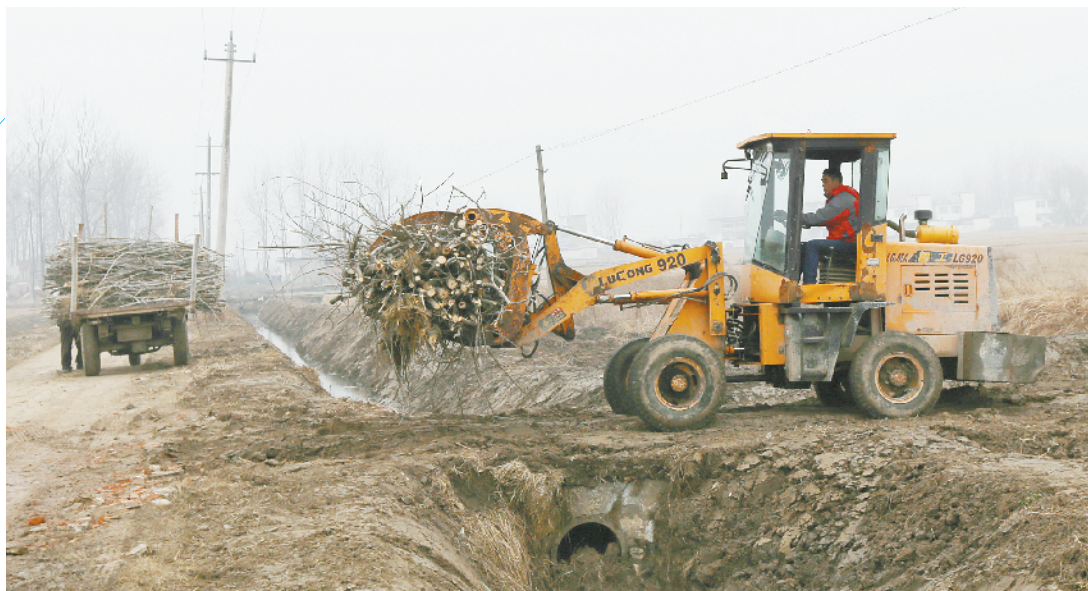
12月10日,在淮滨县期思镇五一村新挖水渠旁,机械设备正在清理杂树树枝,为统一栽种落羽杉做好准备。近日,该镇把“创森”与路、林、沟、渠配套项目紧密结合,对辖区内111公里的县乡村道路全部进行路肩培土,并计划在道路两侧栽植23.8万株“三杉”树苗。朱丝语 秦怡欣 摄
