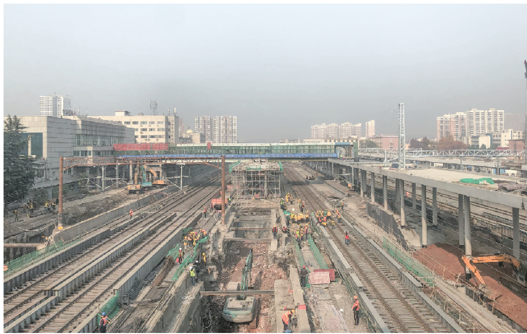
施工现场 本报记者 韩蕾 摄
