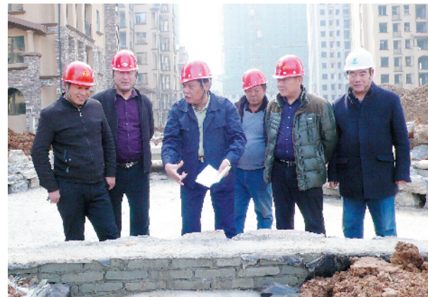
信阳恒大豪庭项目部坚持狠抓施工管理工作,确保建筑工程进度快、质量优,实现了社会效益与经济效益的双赢。图为11月26日信阳恒大豪庭项目部负责人和技术人员在施工现场检查工程质量时的情景。 李建设 摄
