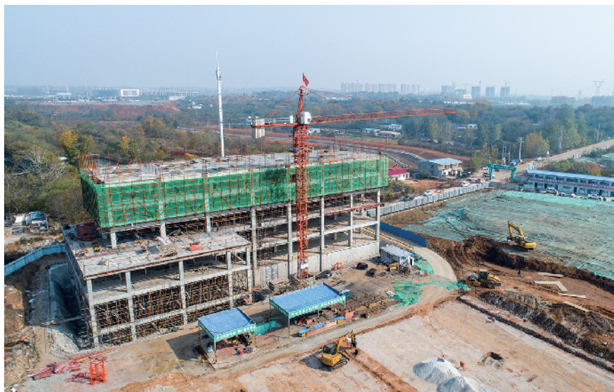
11月1日,记者在位于新十一大街与新三十六大街交叉口区域的信阳市公交中心枢纽站工程施工现场看到,调度指挥中心正在进行混凝土浇筑施工。据介绍,信阳市公交中心枢纽站项目建成后,将对全市公交系统提供保障服务,提高中心城区公共交通能力,方便人民群众日常生活。 本报记者 王哲 摄
