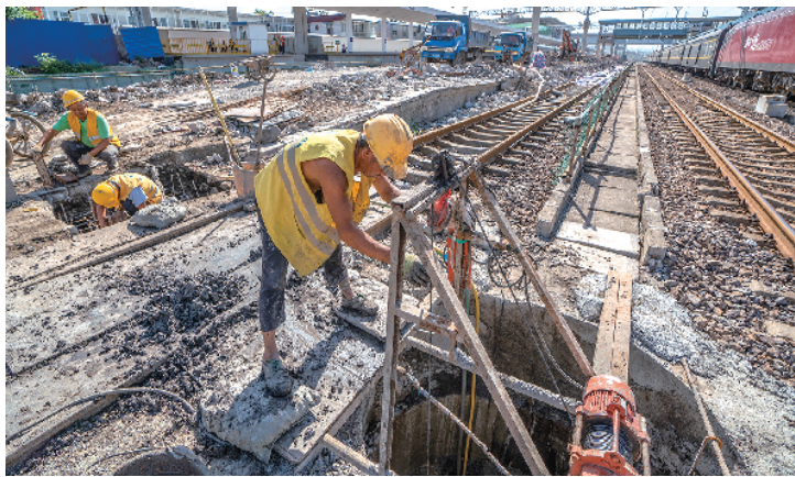
图为施工人员正在进行挖孔桩作业 本报记者 王哲 摄
