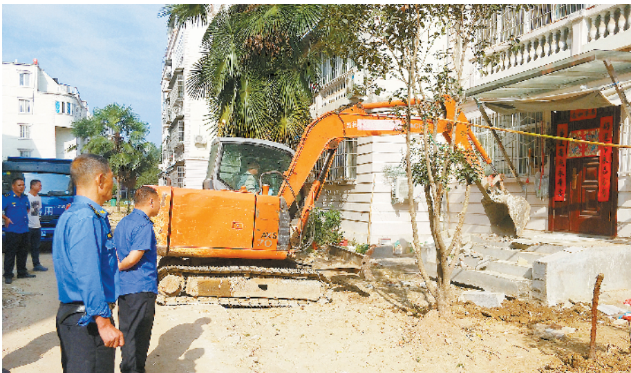
拆除违章建筑
