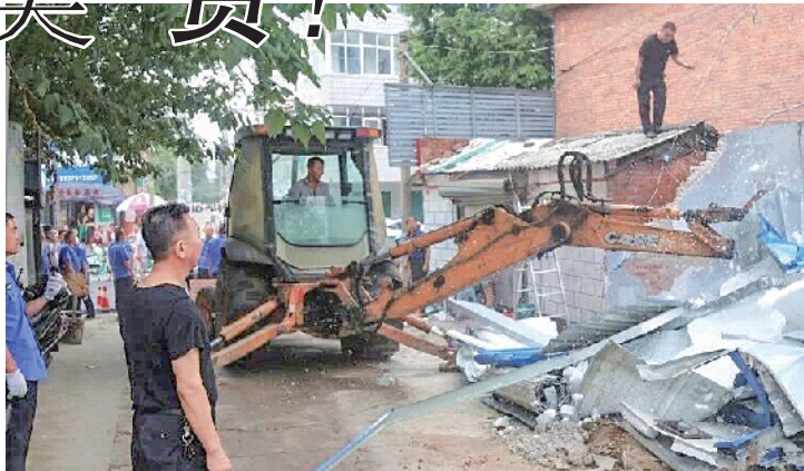
工作人员对违章建筑进行拆除(平西街道供图)
