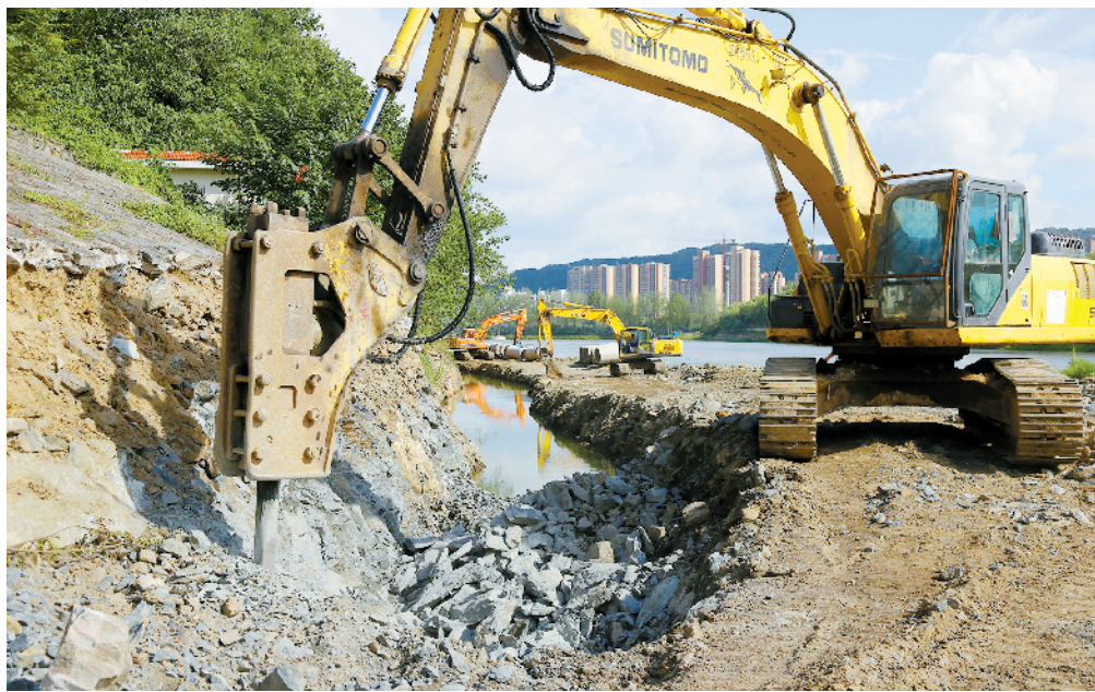
施工现场 本报记者 杨长喜 摄
