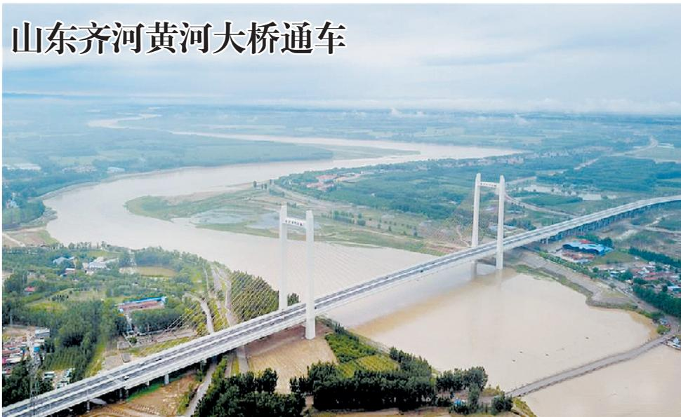
5月16日,山东齐河黄河大桥正式通车。大桥全长3767.9米,主桥840米,桥路基宽35米,采用双向六车道一级公路标准,并预留轨道交通通道。大桥的建成通车将有力改善济南市西部地区与德州市、聊城市及周边地区的交通出行条件。新华社发 吕传泉 摄
