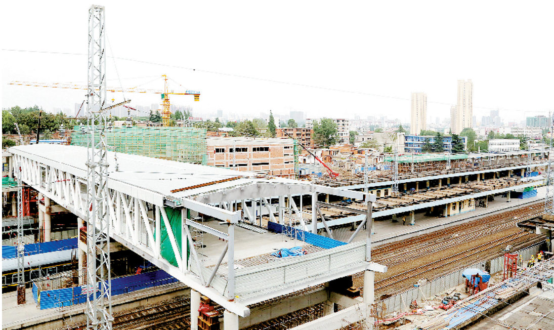
信阳火车站改扩建工程中新建的旅客进站天桥
