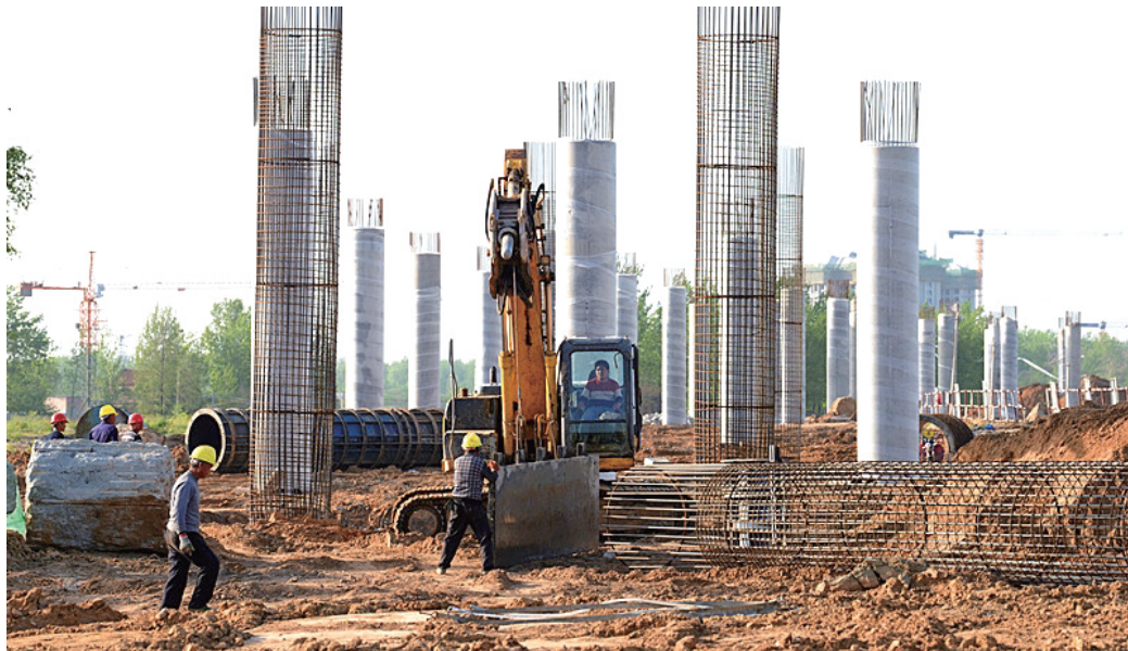
息县淮河大桥及连接线改建工程是市重点项目工程。此大桥建成后,将把息县濮公山地质公园到息县县城距离大大缩短,出行也会更加方便。图为4月11日,施工现场机器轰鸣,施工单位正抢抓时段加班加点施工。
