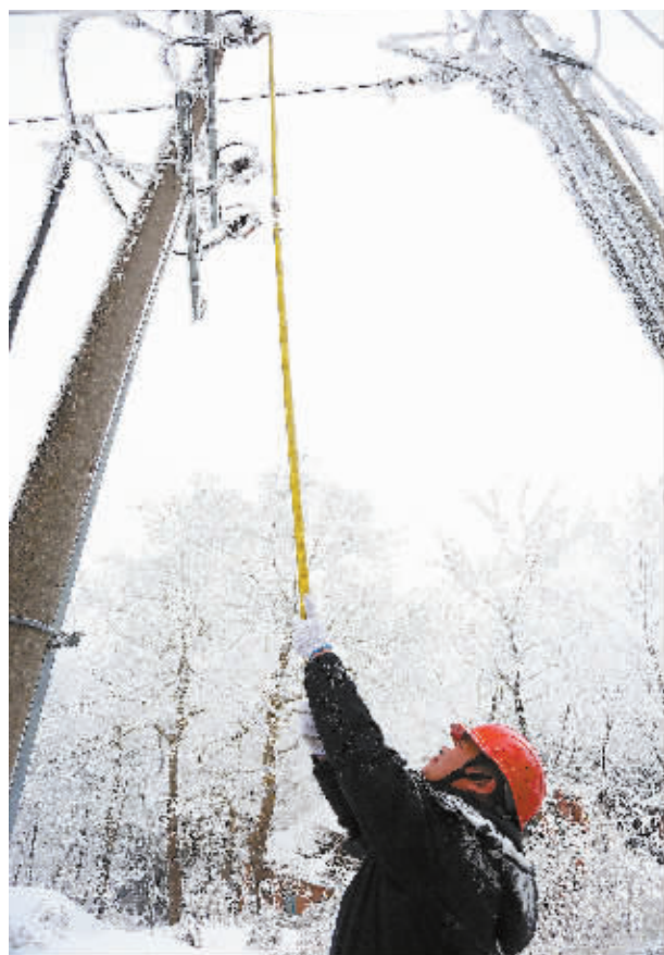
用绝缘杆清理瓷瓶上的积雪
