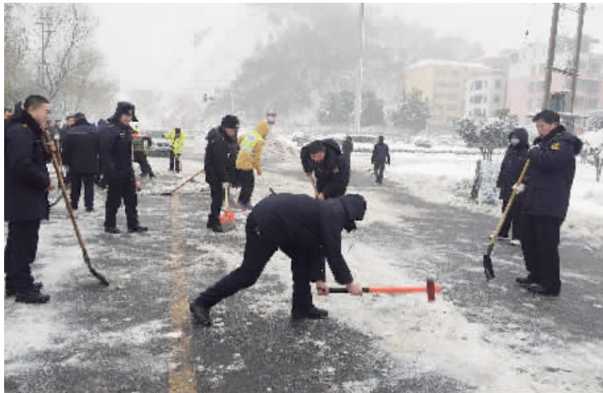
以雪为令,即下即清。自1月3日始至发稿,为确保道路畅通,新县干部职工以单位为小组深入一线开展扫雪除冰工作,县城区道路抛洒融雪剂,动用20台推雪机械连夜进行清理。图为1月6日扫雪除冰现场。 聂建武 程一桐 摄
