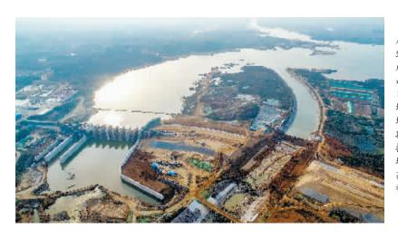
11月30日,记者在出山 店水库导流明渠施工现场看 到,建设者正在紧张施工。在完 成了25个月的导流任务后,出 山店水库导流明渠于11月23 日成功截流。目前,混凝土重力 坝的连接坝段、溢流坝段、底孔 坝段、电站坝段以及非溢流坝 段等主体工程基本完工并具备 挡水和泄洪条件。导流明渠回 填后, 预计12月底达到84米 高程,明年5月底达到95米高 程以上
