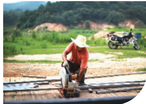
加班加点的建筑工人
