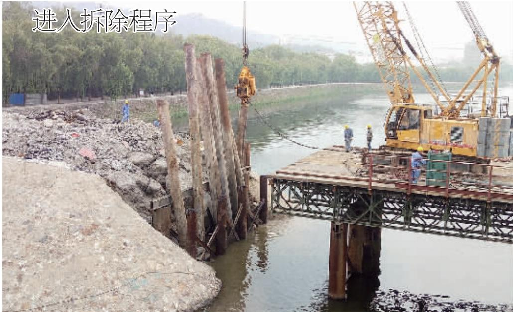
虹桥8月9日恢复通车,当初为了配合改造而搭建的便桥也完成了历史使命。昨日,记者从虹桥便桥拆除现场看到,拔掉基桩过程让人震撼。基桩20多米长,履带吊用尖端的夹子夹住基桩,开始低幅高频振动,不到5分钟的时间,一根基桩就被拔起。虹桥改造项目总工程师李奎介绍说,履带吊设备所能产生的最大力量可达70吨。其中,尖端的振动锤产生的力有20吨,履带吊起重力可达50吨。
