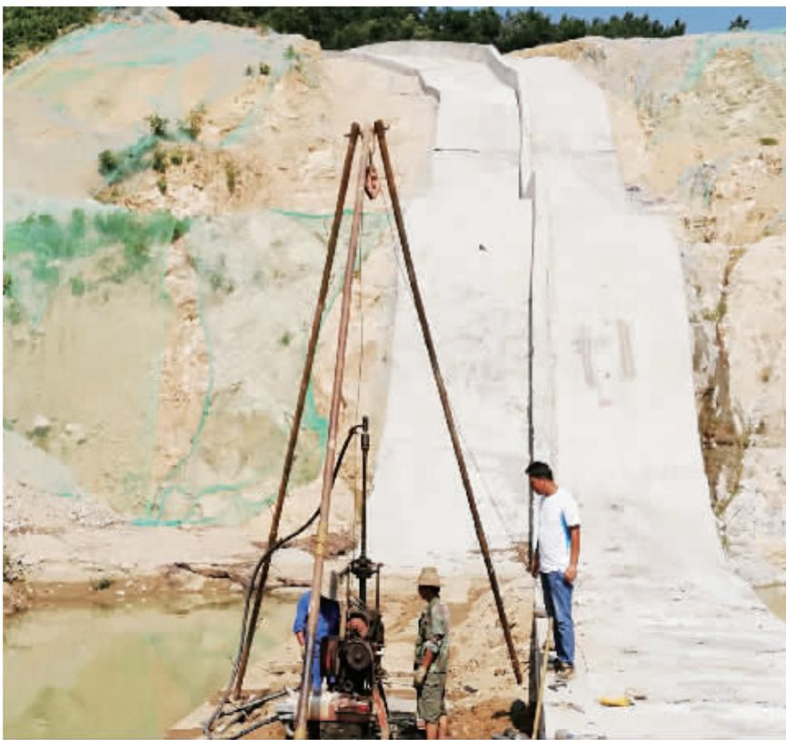
7月24日,鸡公山韦家沟水库施工工地上,工人正冒着高温进行大坝帷幕灌浆工程。该水库建设工程属于市重点项目——鸡公山风情小镇市政基础设施建设项目的一部分,水库设计坝高35米,长度225米,库容130万立方米,建成后能满足小镇5万人用水需求。水库汛期后将进行土方施工,预计年底前建成。
