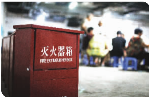
配备的消防器材
