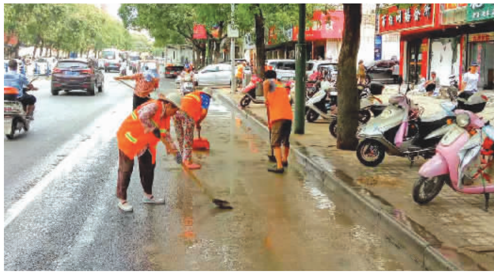
20日凌晨5时许,我市环卫部门组织环卫工人30余人,出动5吨清扫车5辆,高压冲洗车3台,道路养护车5台,小型清扫车3台,垃圾收集车3台,加班加点对北京路供水管道爆裂引起的路面泥沙进行集中清理,持续加强道路路面保洁力度,保障市民出行和市容市貌。 首席记者 韩蕾 摄
