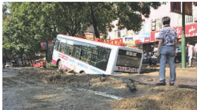
供水管道破裂导致一辆9路公交车被“坑” 本报记者 周涛 摄
