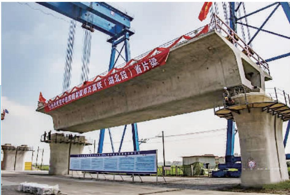
7月10日,郑(郑州)万(万州)高铁湖北段首片箱梁在湖北省襄阳市襄州区境内的白河特大桥开始架设,标志着郑万高铁湖北段架梁施工全面展开。郑万高铁全长818公里,设计时速为350公里,预计2022年全线建成通车,其中郑州至襄阳段预计2019年底建成通车。
