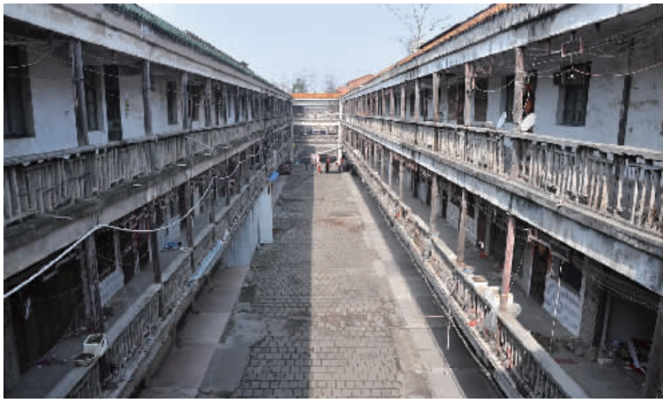
即将被拆除的浉河大市场局部。 马保群 摄
