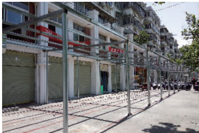
“阳光走廊”框架已搭起 本报记者 杨长喜 摄
