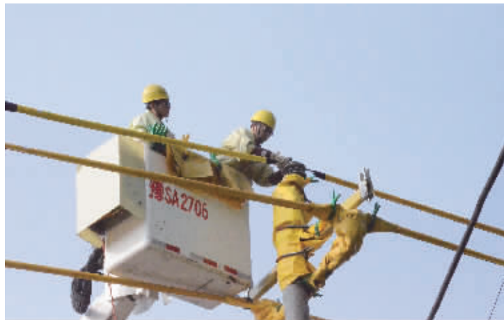
施工现场 本报记者 杨长喜 摄
