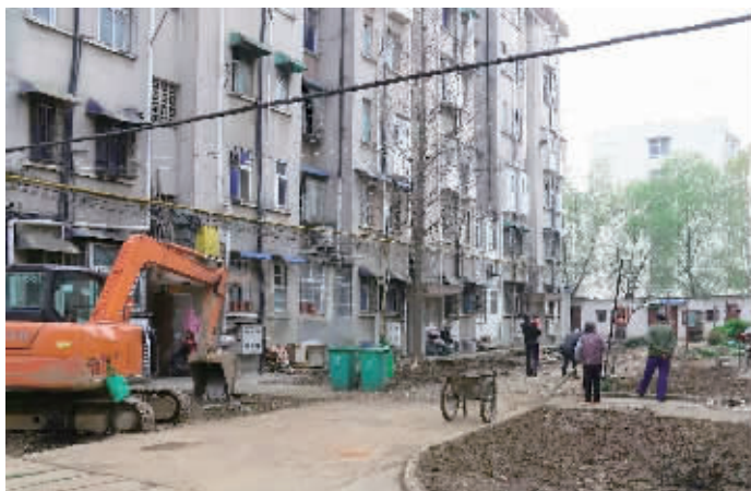
挖掘机正在平整磷肥厂家属院的公共绿地
