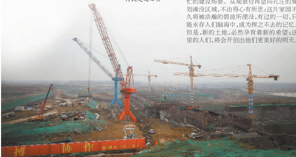
出山店水库坝区施工现场
