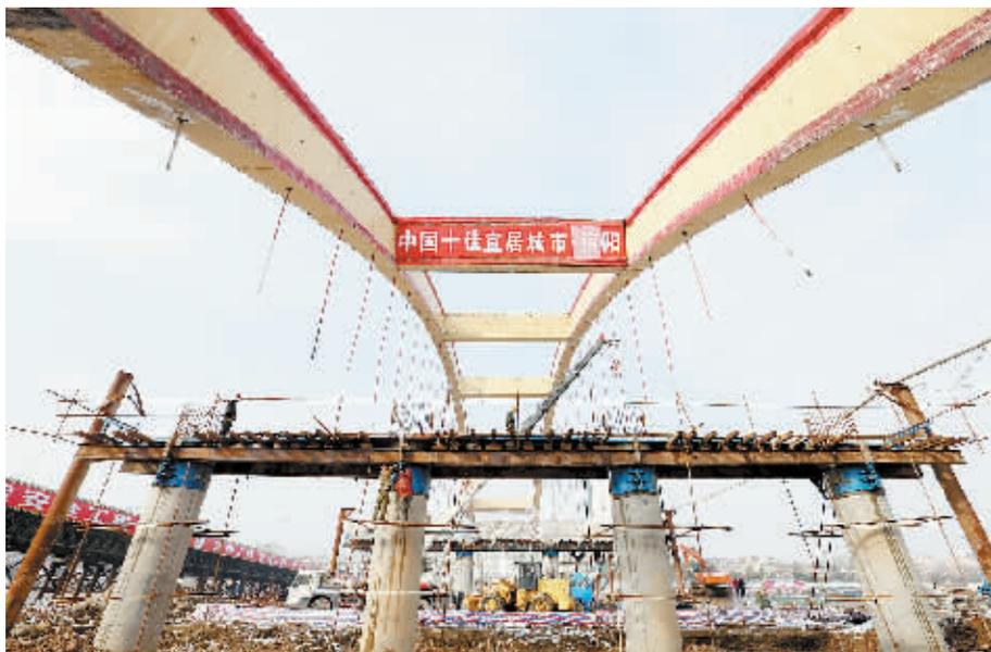
备受市民关注的107国道虹桥改造工程正在加快施工进度,昨日,记者在现场看到,工地上机器轰鸣、火花四溅,工人们正在按照施工进度有条不紊地进行施工。据了解,大桥的立柱已经完工,盖梁也进入吊装养护阶段。本报记者 郝光王哲 摄
