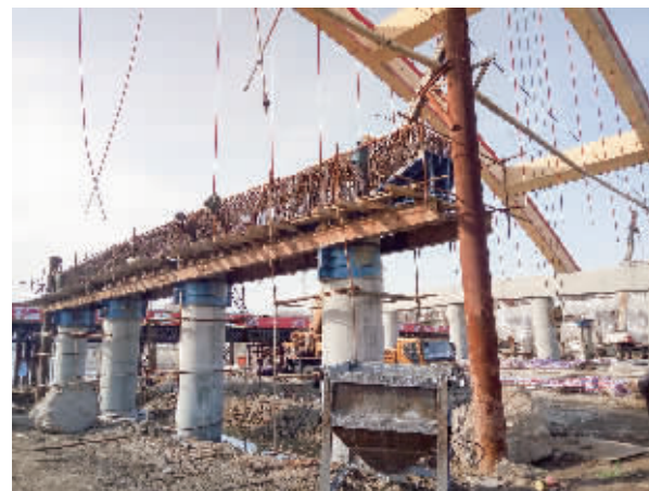
施工现场 本报记者 杨长喜 摄
