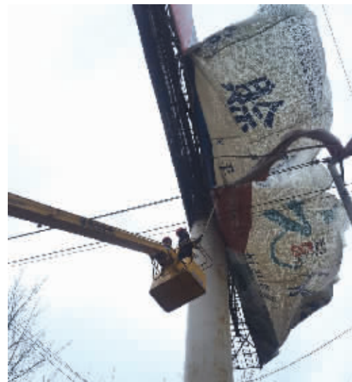
图为电业人员正在移除广告布牌
