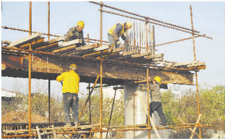
跨宁西铁路立交桥施工现场 首席记者 韩蕾 摄
