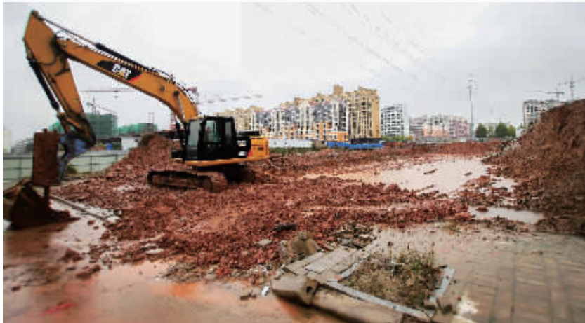
新申河东支施工现场 首席记者 周涛 摄
