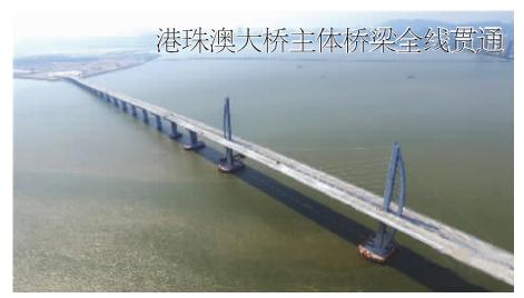
这是港珠澳大桥九洲航道桥的风帆造型桥塔 (9月27日摄)。 9月27日,港珠澳大桥主体桥梁正式贯通。港珠澳大桥是连接香港、珠海、澳门的超大型跨海通道,全长55公里。
