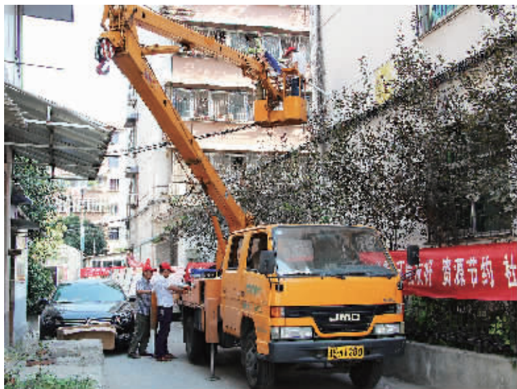
工作人员正在安装路灯 首席记者 韩蕾 摄
